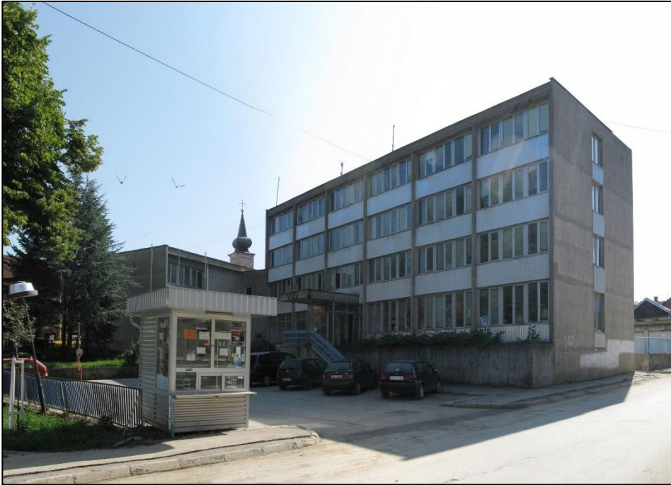
Стање прије реконструкције наикадшње управне зграде компаније „Боксит“
